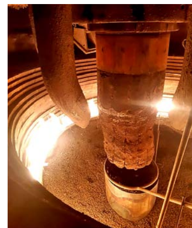
Сушка футеровки и обжиг электродов горелками
