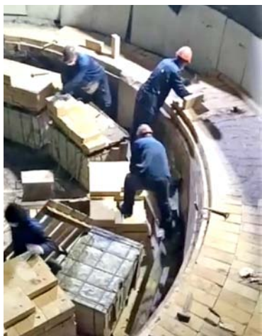
Работы по футеровке ванны печи
