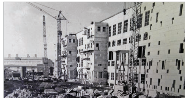
Стройка в июне 1963 года. Возведение стены главного корпуса
