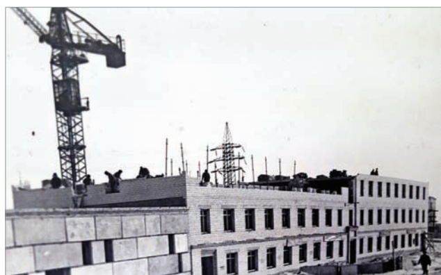
Строительство бытовых помещений цеха
