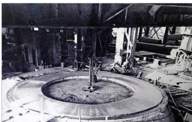
Закладка первого фундамента печи № 41
