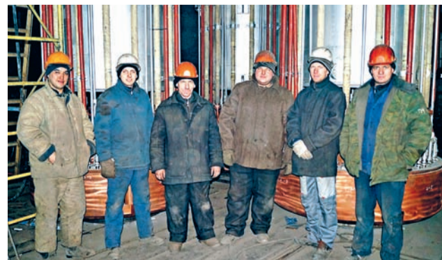
На фото: бригада ЦРМО, ведущая монтаж токопровода 42-й печи. Слева направо: Р. Илимбаев, Д. Бочкарев, Ю. Рябов, А. Боз, К. Нетреба, В. Нестеров
