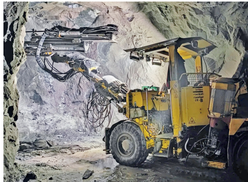
Буровая установка Boomer-282 в работе (Харп)
