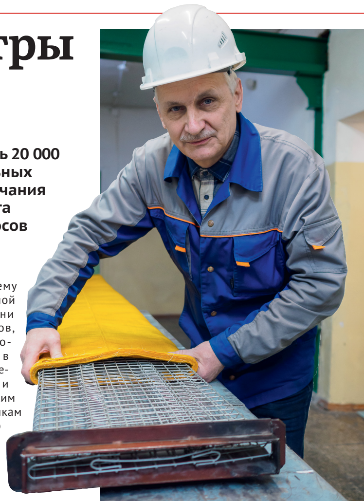
Зам. главного энергетика Александр Громов проверяет фильтр
