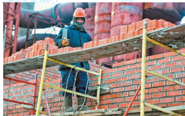
Растут стены новой насосной
