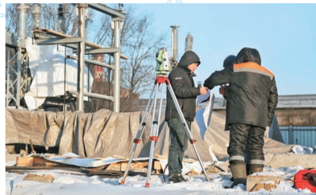
ГПП-4 на этапе завершения
